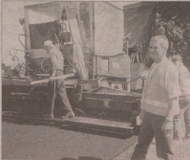
Jerzy Samagalski, kierownik budowy i Zbigniew Strzałkowski, operator walca, podczas układania nowej nawierzchni.
