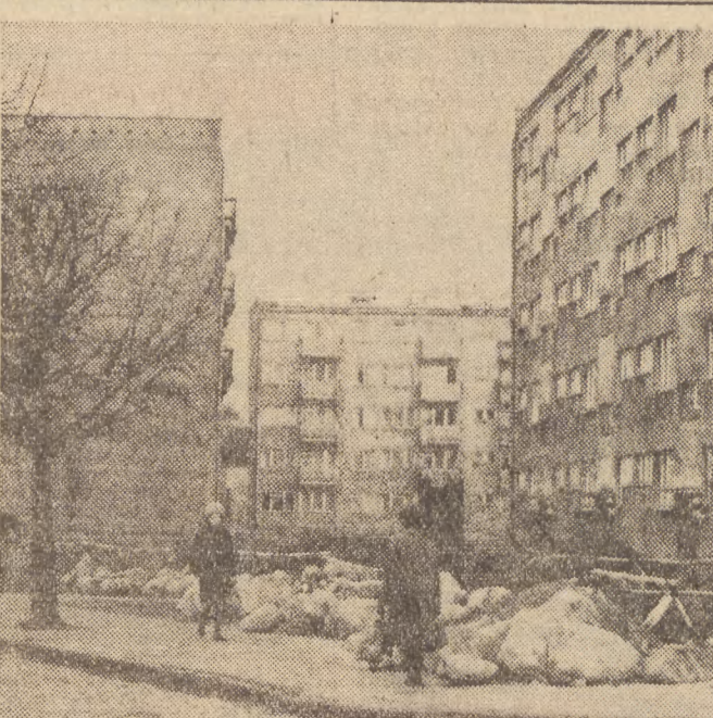
Kopacze są już na ulicy Garnarskiej. Piękne osiedle spółdzielcze, którego mieszkańcy poświęcili wiele czasu na urządzenie zieleni i trawników, zostało rozkopane, zresztą jak wiele innych ulic Słupska.
