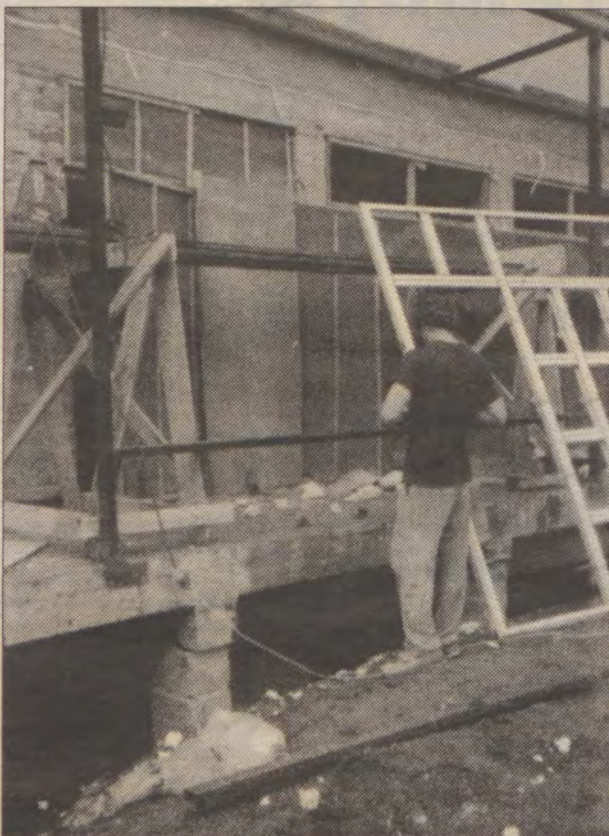
Mimo iż w Rumi wiele się buduje, w upalne dni trudno spotkać kogoś na budowie.
