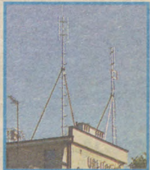
Anteny na budynku przy ul. Dąbrowskiego.
