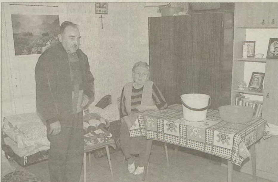
Jadwiga i Bolesław W. martwią się. Z sufitu w dalszym ciągu kapie woda, a prognozy pogody zapowiadają kolejne deszcze.
