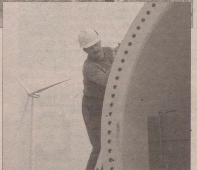
Postawienie wiatrowych kolosów wymaga dużej precyzji. Na zdjęciu pracownicy duńskiej firmy montują podstawę wiatraka.
