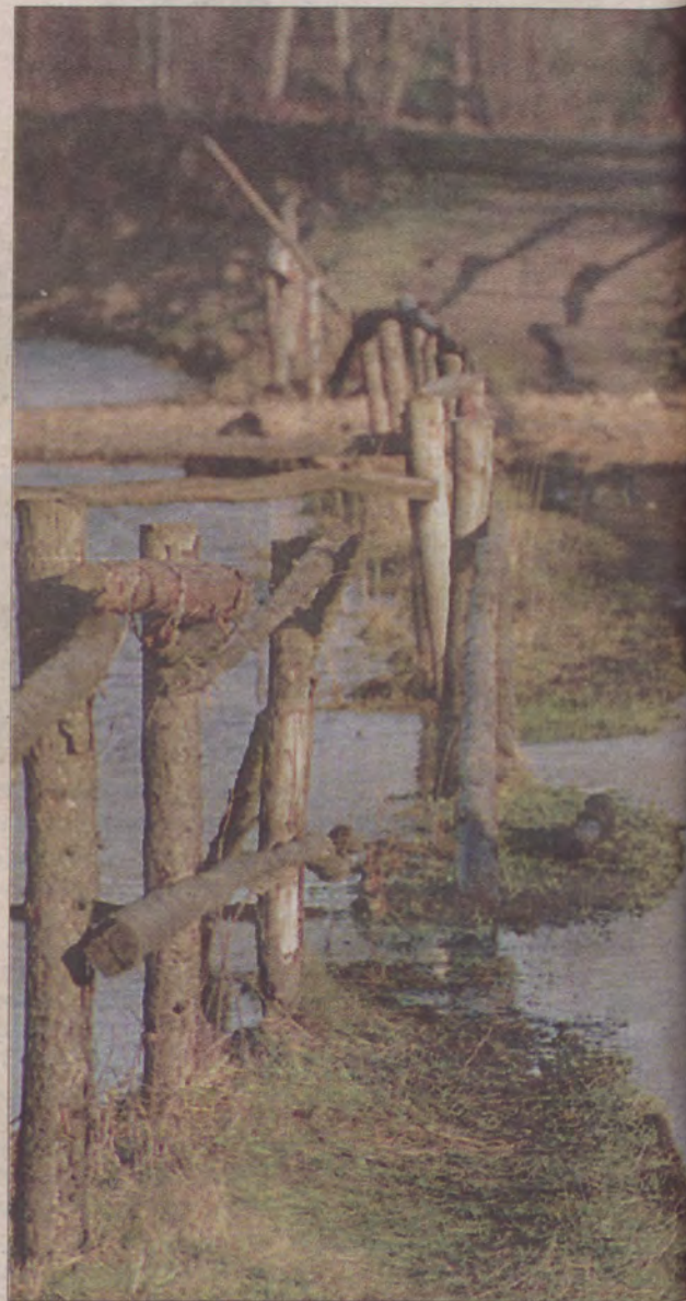
Woda z zalanej drogi w Wejherowie wlewa się do gospodarstw.
