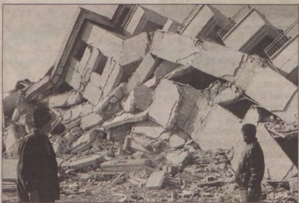
Zniszczony dom w środkowej Turcji.
