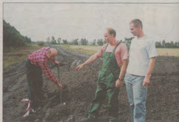
Piotr Libner, Zbigniew Dawidowski i Piotr Machlik podczas pracy przy budowie drogi.
