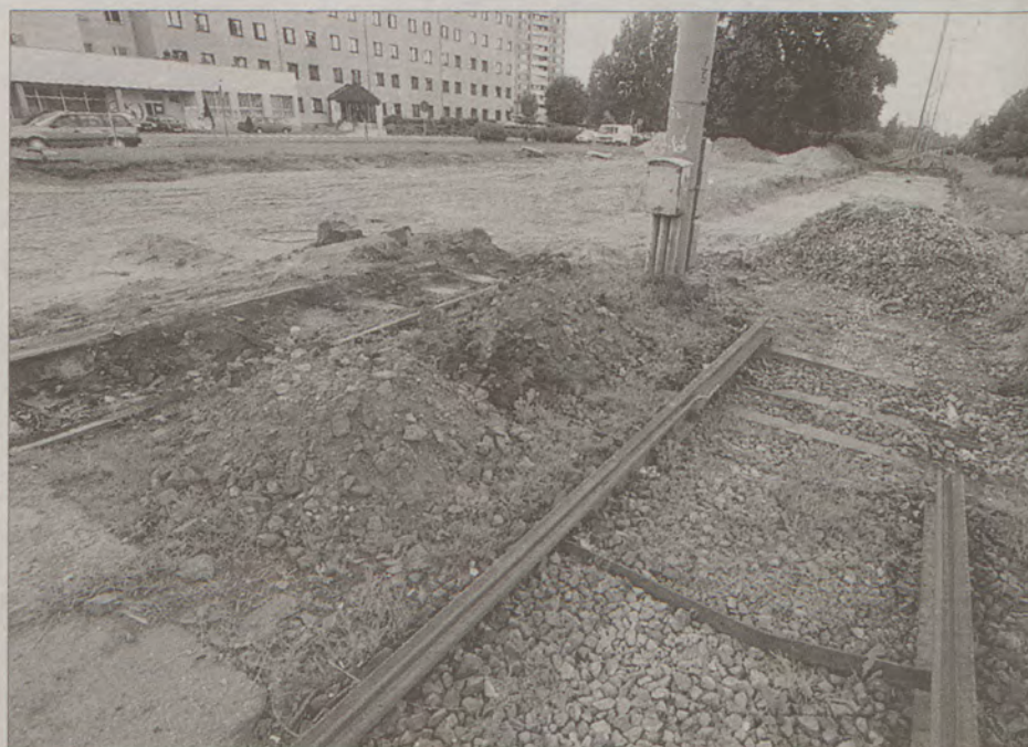
Remont torowiska na skrzyżowaniu ul. Chłopskiej i Kofobrzeskiej na gdańskim Przymorzu ponownie się opóźni.
