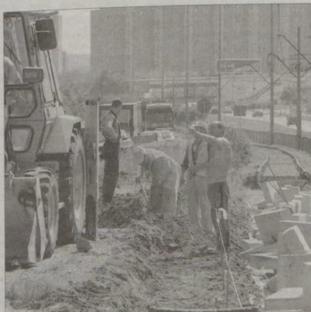
Trzy miesiące minęły zanim wznowiono remont rozkopanych torów na Przymorzu.
