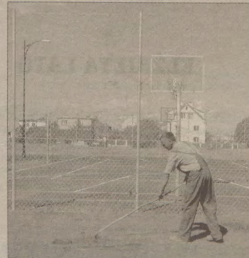
Ostatnie prace porządkowe przed oddaniem boiska do użytku.
