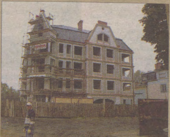
Jest dach - nie ma wiechy, a przynajmniej jej nie widać. Za to ma się dobrze płótek okalający.
