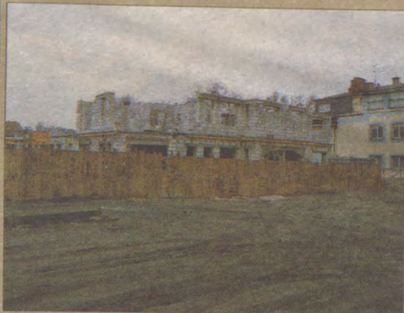
Po fundamentach są już pierwsze piętra - ogrodzone drewnianymi palikami.
