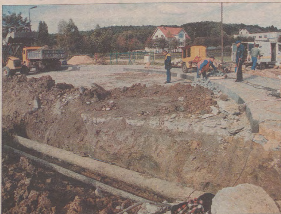
Roboty przy pętli autobusowej trwają już ponad dwa miesiące.
