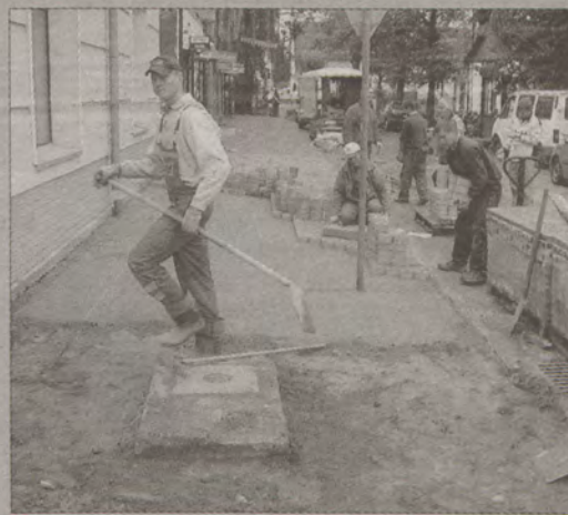
Trwa układanie chodnika przy ul. Grunwaldzkiej w Pruszcze Gd. Fot. Wawrzyniec Rozenberg
