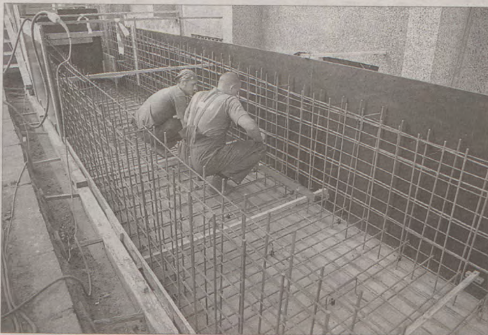
Wielkie zmiany w Akwarium Morskim już się zaczęły. Podjazdy dla wózków inwalidzkich prawie ukończone.
