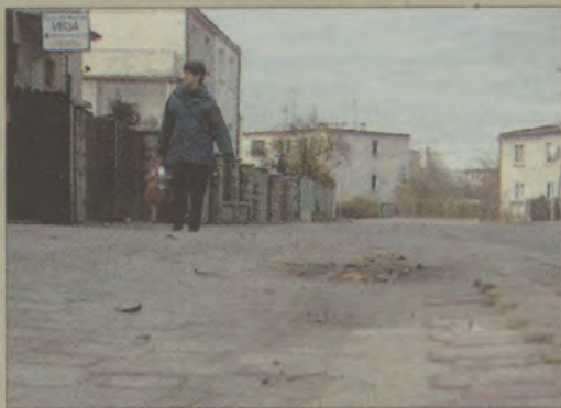
Nawierzchnia zostanie naprawiona w przyszłym tygodniu.
