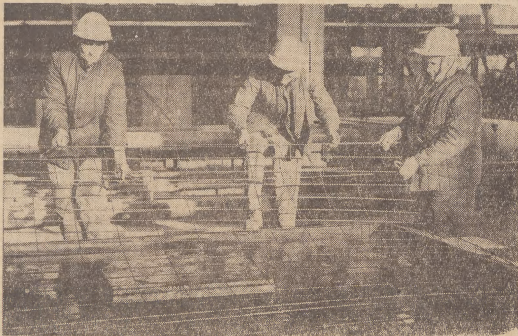
W grudniu rozpoczęto rozruch technologiczny nowych szczecińskich Zakładów Produkcji Betonów „Gryfbet”. Fabryka ta już w 1974 roku ma dostarczyć ponad 4 tysiące izb mieszkalnych, a w 1975 — po uzyskaniu pełnych zdolności produkcyjnych — ponad 7 tysięcy izb „Gryfbet” jest szóstą wytwórnią opartą na licencji i urządzeniach radzieckich. Na zdjęciu: zbrojenie płyt.
