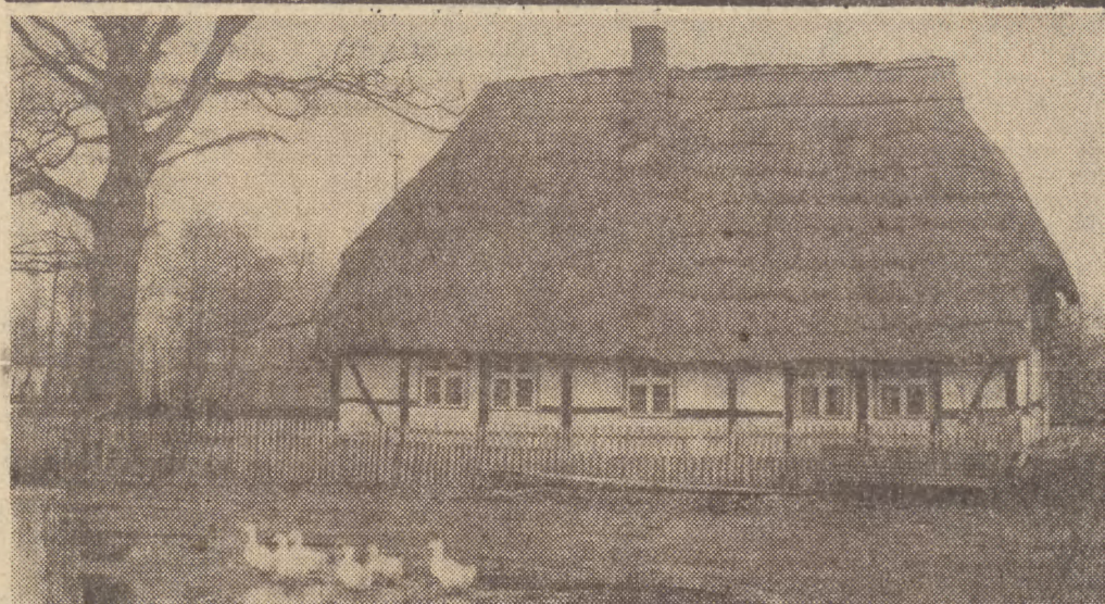
W Dąbkach (pow. sławieński) zachował się unikalny zespół zabudowań rybackich z połowy XIX stulecia. Jest to pięć chat budowanych systemem szachulcowym oraz jedna zagroda. Z pewnością warto by tu urządzić skansen przyworskich budownictwa rybackiego, a może — również z myślą o turystach — otworzyć zajazd lub karczmę? (w)
