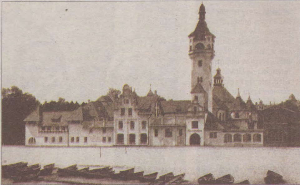
Widok zakładu kąpieli ciepłych od strony morza. Rok 1908.
