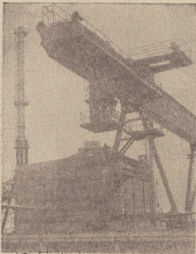
Na pierwszym planie wielka suwnica do mechanicznego rozładunku węgla, w głębi — kotłownia. Fot. W. Wiśniewski
