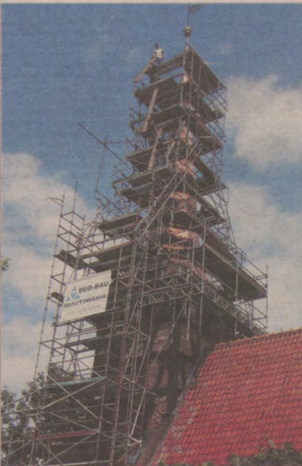
Mieszkańcy Osic odremontowali wieżę zabytkowego kościoła.
