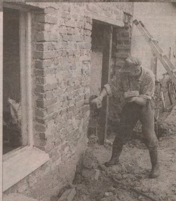
Już niedługo Morzeszczyn będzie mógł poszczycić się nowoczesnym parkingiem. Na zdjęciu Wiesław Nadolski podczas rozbiórki domu, na miejscu którego powstanie parking.
