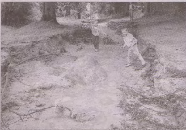
Powódź zniszczyła wiele dróg w powiecie tczewskim, m.in. w Widlicach.
