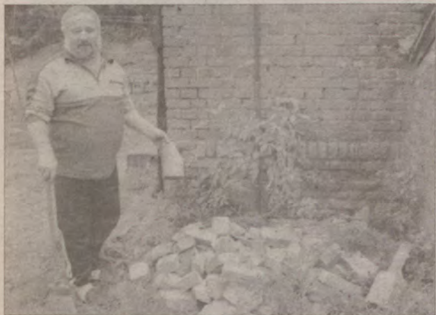
Andrzej Różanowski z ul. Wąskiej 15 w Tczewie, przy stercie cegieł, które spadły z okna.
