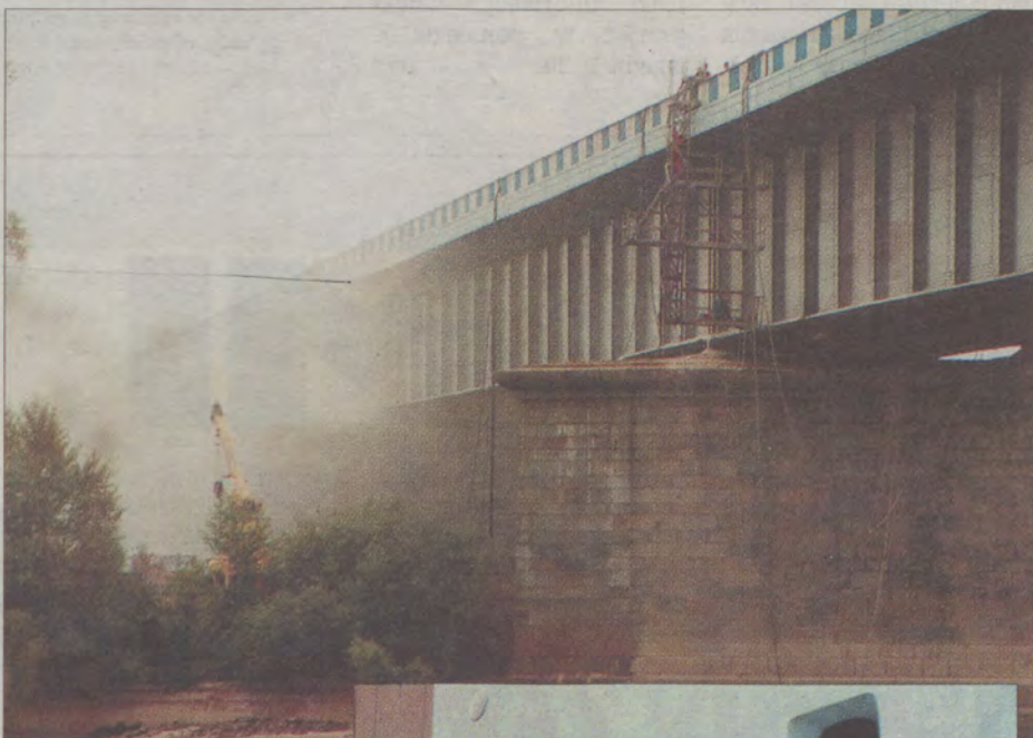
Obecnie most jest czyszczony i gruntownie remontowany.
