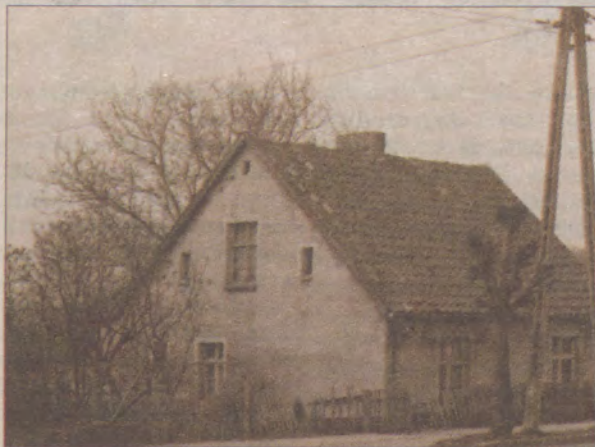
Tak wyglądał budynek przy ul. Gdańskiej w Gniewie przed ponad dziesięciu laty. Został rozebrany pod koniec lat osiemdziesiątych.
