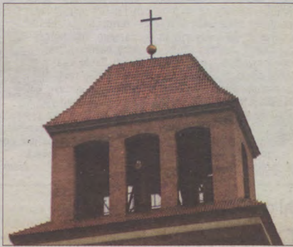
Obecnie cała wieża kościoła jest zbudowana z cegły.
