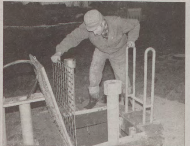
W Czarlinie trwają prace związane z budową kanalizacji. Na zdjęciu Zdzisław Kotowski.
