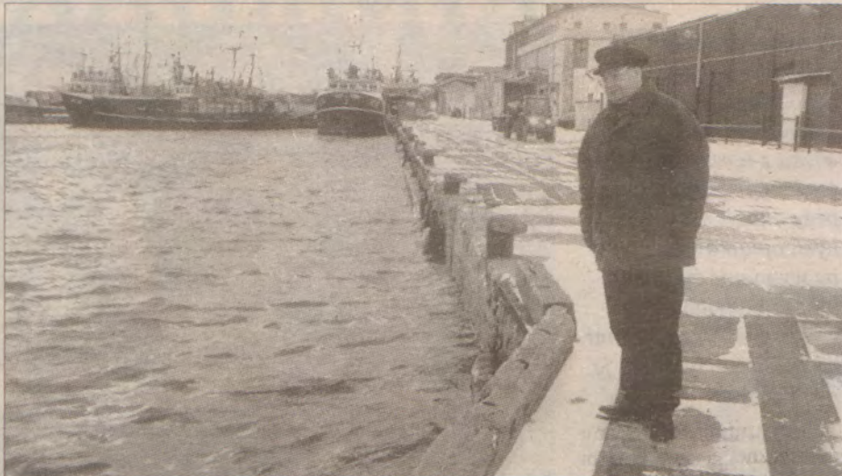
Jedną z inwestycji realizowanych w powiecie puckim będzie modernizacja portu w Helu, radny powiatowy Jan Muża nad zniszczonym nabrzeżem.
