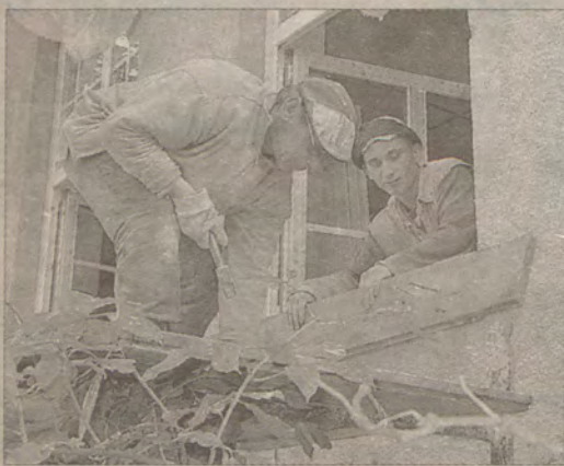
Michał Sowa z synem Dominikiem montują okno w świetlicy w Złotowie.
