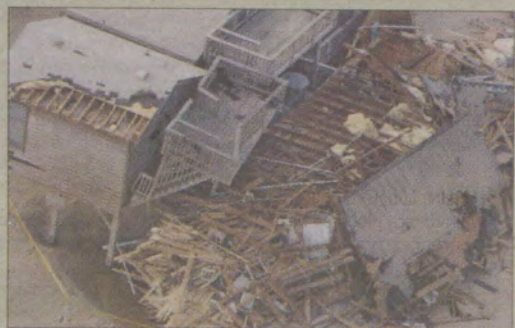
Ruiny motelu zniszczonego przez huragan w miejscowości Hatteras.
