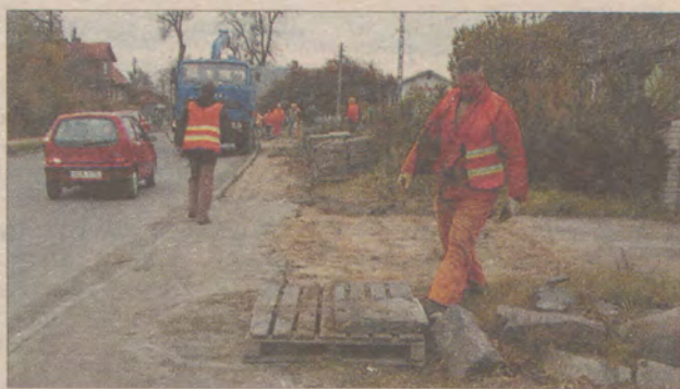
Trwa remont drogi nr 221 w Kolbudach.
