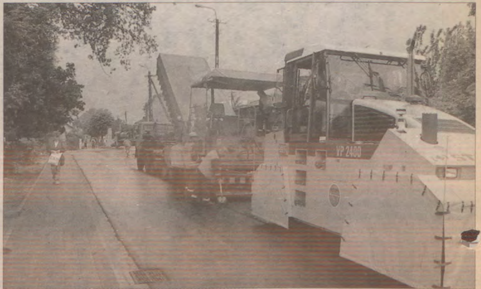
Remont ulicy Szkolnej był możliwy dzięki środkom Unii Europejskiej.
