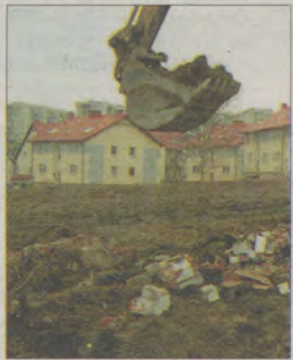
Z powodu budowy stacji benzynowej przy ul. Małomiejskiej rozebrano kapliczkę. Na nowo pojawi się po zakończeniu budowy.
