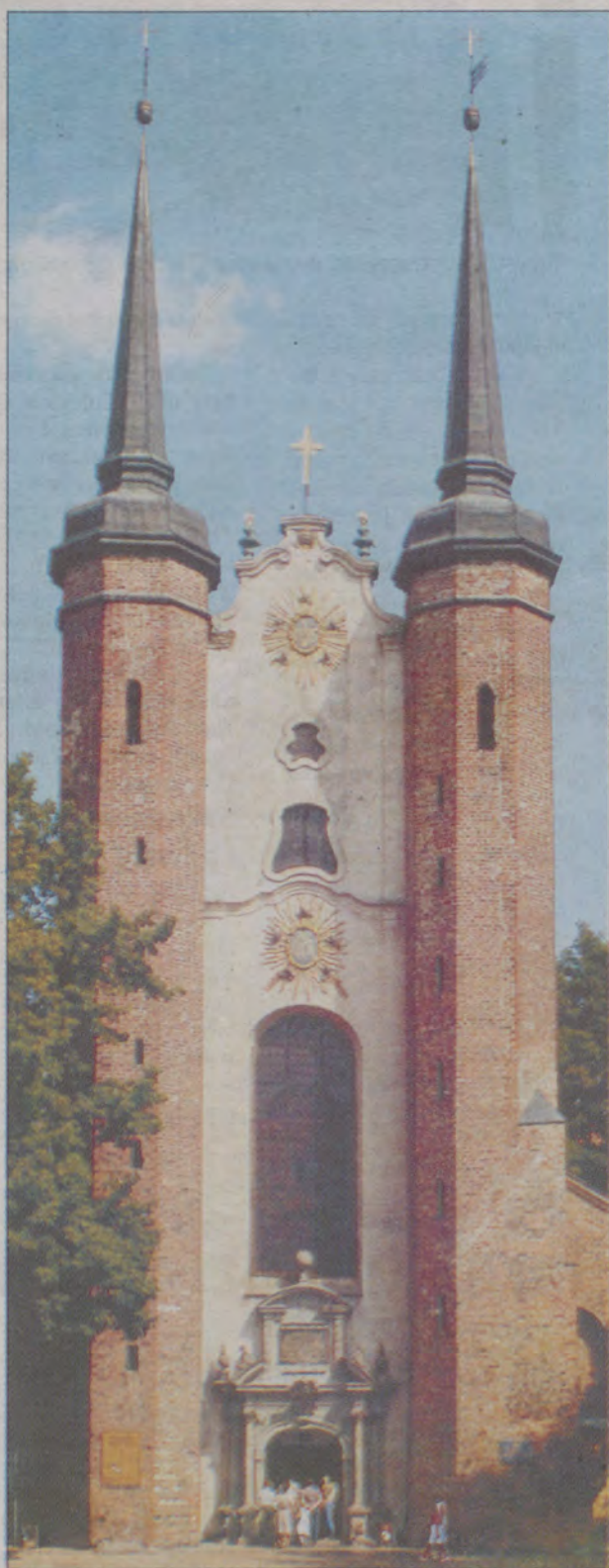
Zachodnia fasada kościoła - przebudowana i ozdobiona w latach 1770-1771 na polecenie opata Rybińskiego.
