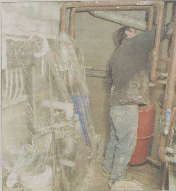
ABK nr 3 i PZU S.A. dotrzymały słowa – dzisiaj w domu przy ul. 10 Lutego 18 zacznie działać centralne ogrzewanie. Wczoraj trwały ostatnie prace.
