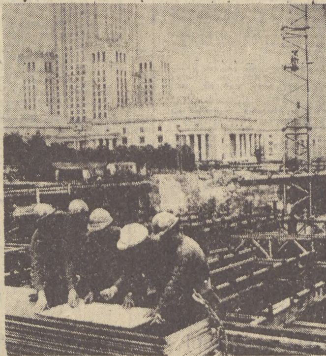
Na jednym z największych w stolicy placów budowy — w rejonie wznoszonego Dworca Centralnego — pracują żołnierze Wojsk Komunikacyjnych, którzy wyspecjalizowali się w montażu skomplikowanych konstrukcji.
