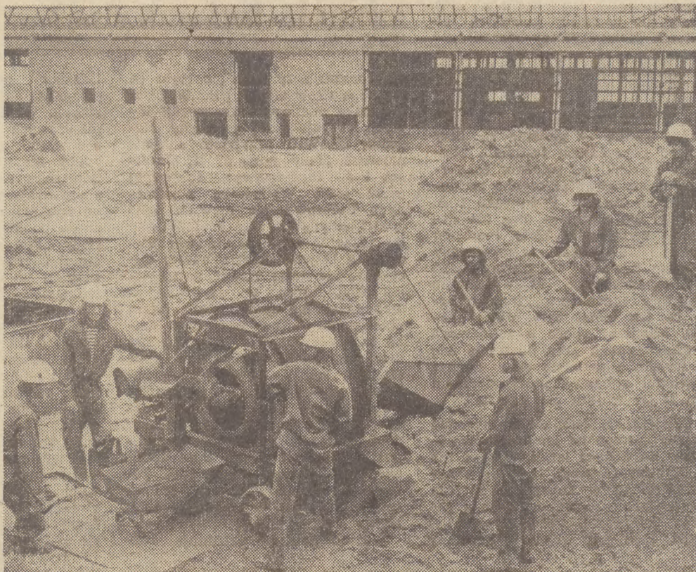
Na zdjęciu: Junacy przyrządzają zaprawę cementową do wylewania posadzek w hall warsztatów mechanicznych Fot. L. Wojtkiewicz
