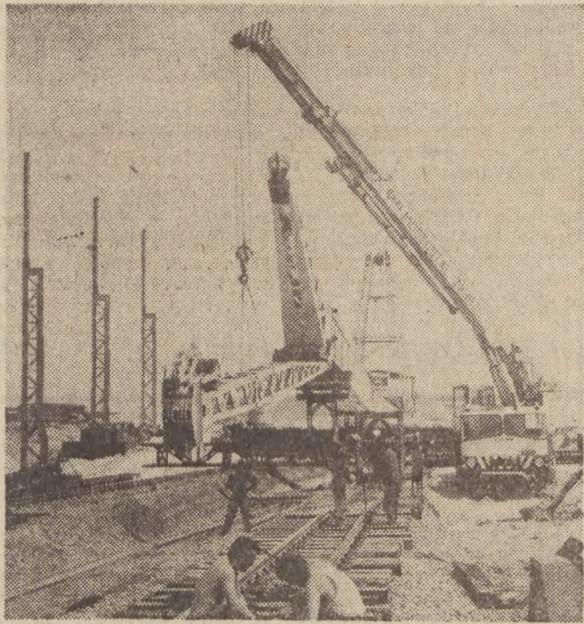
Na budowie Huty Katowice – mimo pory urlopowków, rytmika i tempo wykonywanych zadań nie słabną. Od kilku mipsiey prace koncentrują się na podstawowych obiektach: budowy walcowni, stalowni, bloków administracyjno socjalnych. Montażu konstrukcji podjął się MN tonaż z Zabrzeża i nad całością realizacji czuwa zespół specjalistów z C&I Ostalu—4.
