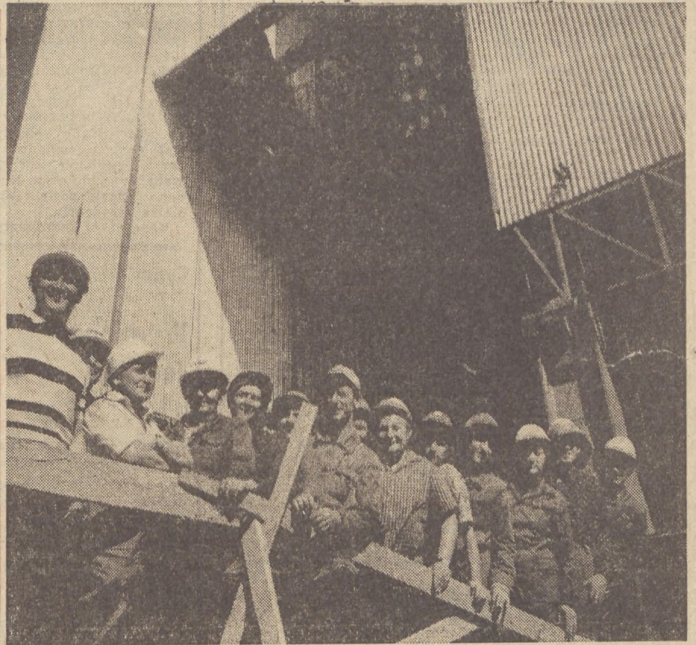
Kilka dni temu w budującej się kopalni „Pniówek” ROW dokonano trudnej operacji — przesunięto na odległość 75 metrów wieżę główną szybu „Ludwik”. Ta skomplikowana operacja pozwoli na przyspieszenie rozruchu kopalni. Na zdjęciu — zespół specjalistów, którzy dokonali przesunięcia.
