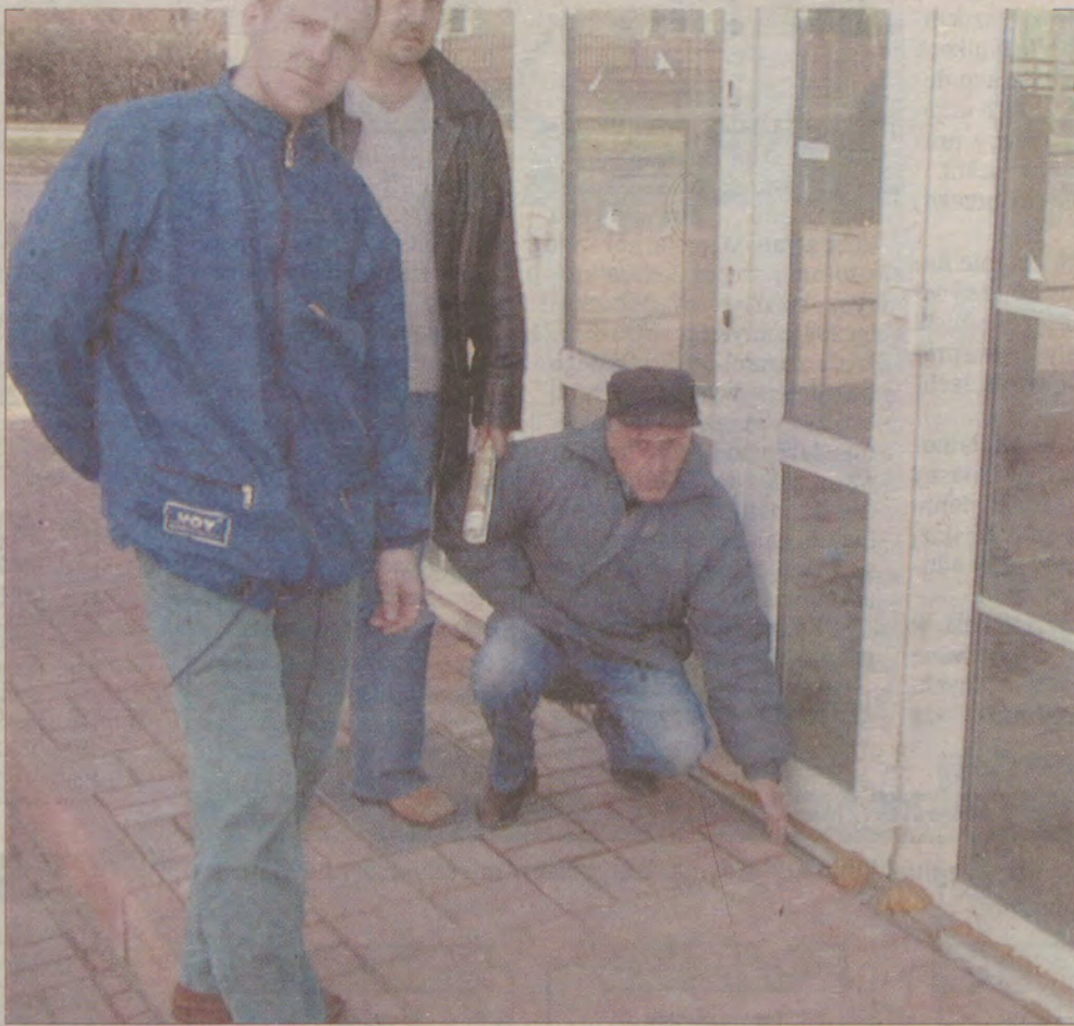
Mieszkańcy domu przy ul. Sychty pokazują usterki obiektu.
