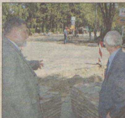
Prace przy puckiej podstawowce.
