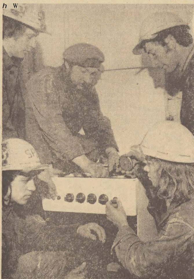
Bp/gada Edwarda Kendelskiego (brygadzysta w środku) omawiać sposób zainstalowania kuchenki gazowej w mieszkaniu.
