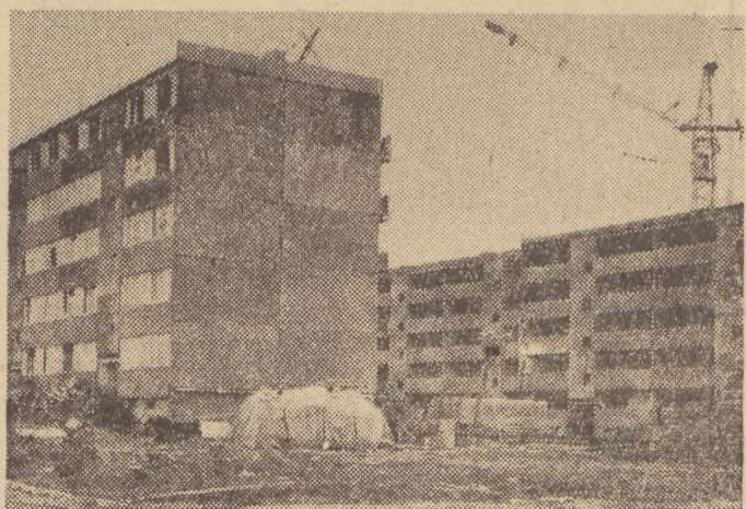
Wytwórnia elementów OWT dostarcza płyty na budowę domów nowego osiedla Westerplatte.
