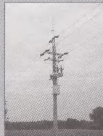
Конструкция под радиоуправляемый разъединитель 15 кв с МОЛНИЕОТВОДОМ
