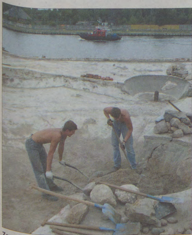
Zaczęła się renowacja Twierdzy Wisłoujście, cennego zabytku morskiej architektury obronnej.
