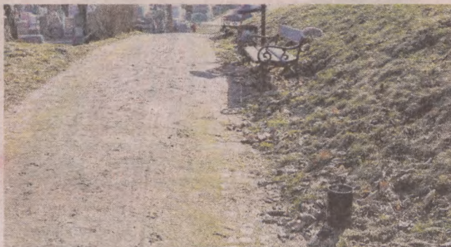
Zniszczone lampy na ścieżce przy cerkwi
