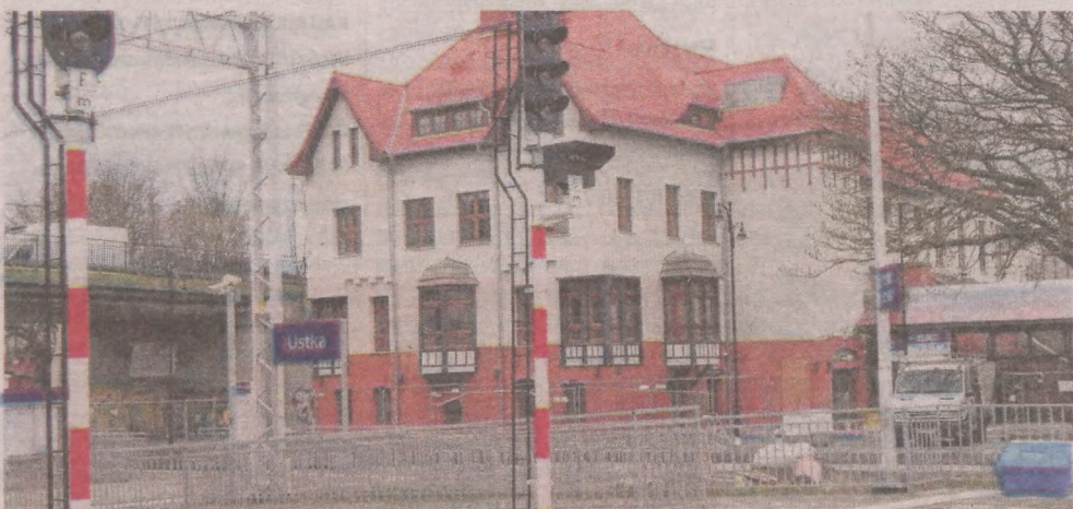
Wartość całej inwestycji obliczono na ok. 44 mln złotych
