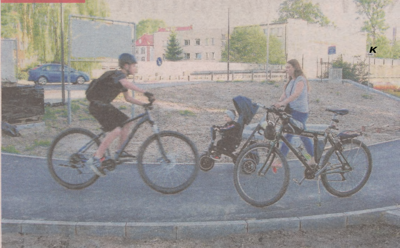
Efekt rewitalizacji bulwarów nad Słupią jest ta oto 160-metrowa ścieżka pieszo-rowerowa
