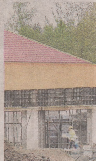
Budowa trzeciej Biedronki i pawilonów handlowych
