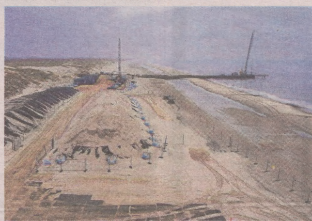
Tak niedawno wyglądał plac budowy 200-metrowego mola w Housstrup Strand, niedaleko Noerre Nebel na Jutlandii
