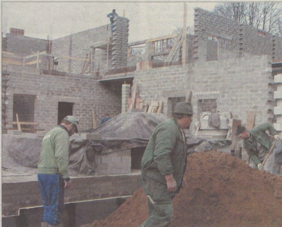
Prace przy budowie szkoły posuwają się zgodnie z planem. Niektórzy boją się jednak, że długi szpitale mogą wpłynąć na ich wstrzymanie.
