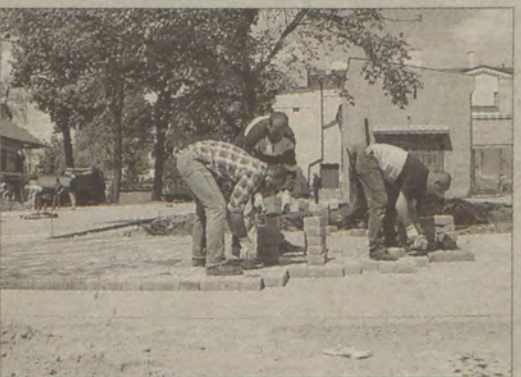
W lipcu i sierpniu w ruch poszły silne męskie ręce. Robotnicy przez kilka tygodni stukali w kostkę młotkami i układali polbruk.
