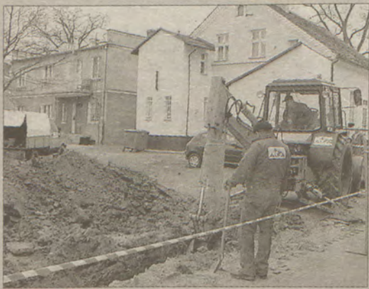
Prace ziemne rozpoczęły się w marcu. Najpierw wykopano rowy pod instalację...
