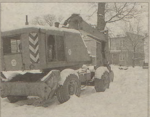
Niestety 10 kwietnia trzeba było przerwać prace z powodu nagłego powrotu zimy.
