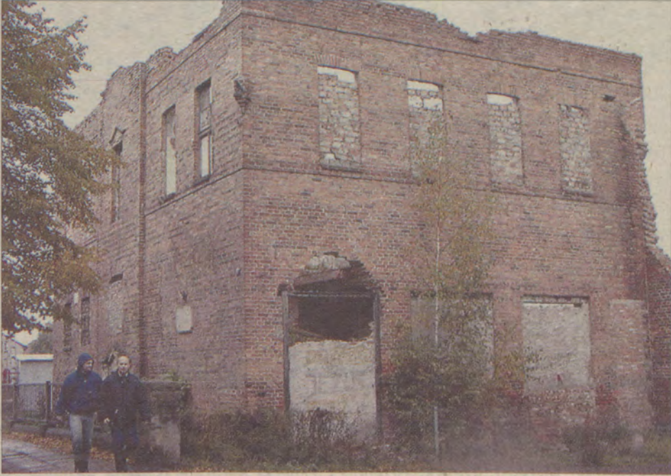
Tuż po wojnie elektrownia produkująca prąd dla Kwidzyna i okolic mieściła się przy ul. Wiślanej.
